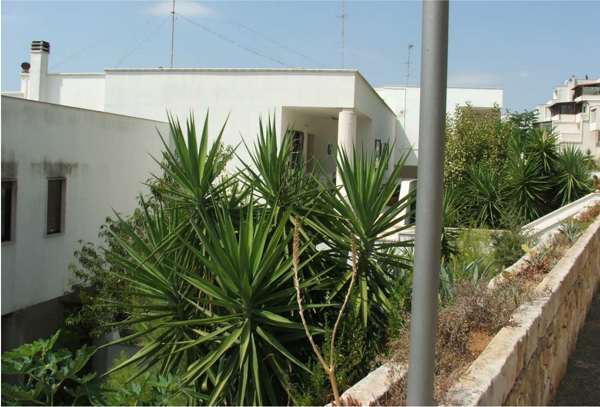
Fig.12 – Vista degli edifici esistenti nella zona C.e.2.4 di intervento
