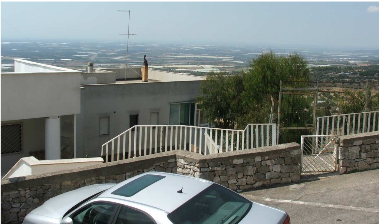
Fig.7 – Vista degli edifici esistenti nella zona C.e.2.4 di intervento
