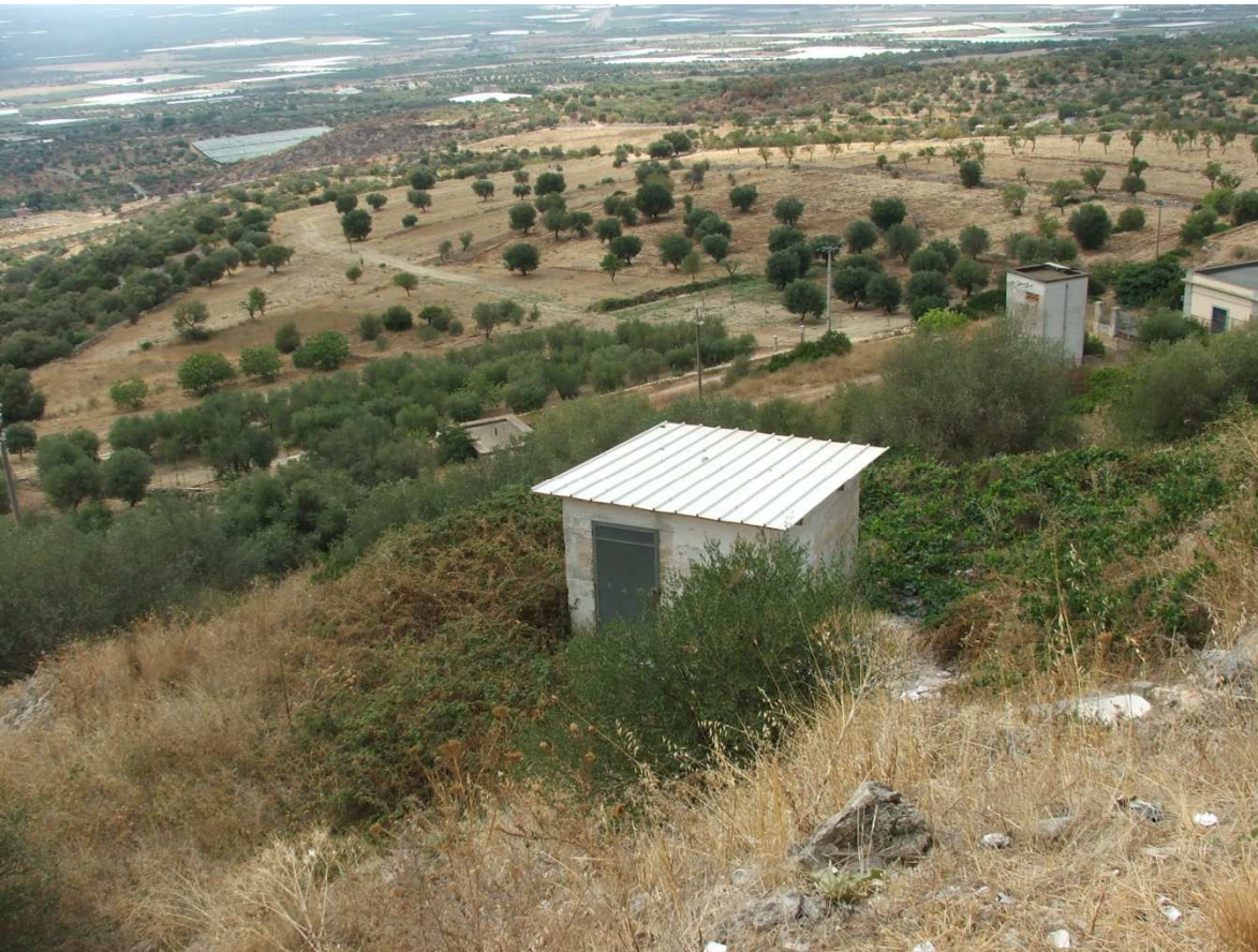
Fig.15 – Vista dell'area interessata e del vano pompa di sollevamento della fognature a servizio degli edifici esistenti nel C.e.2.4
