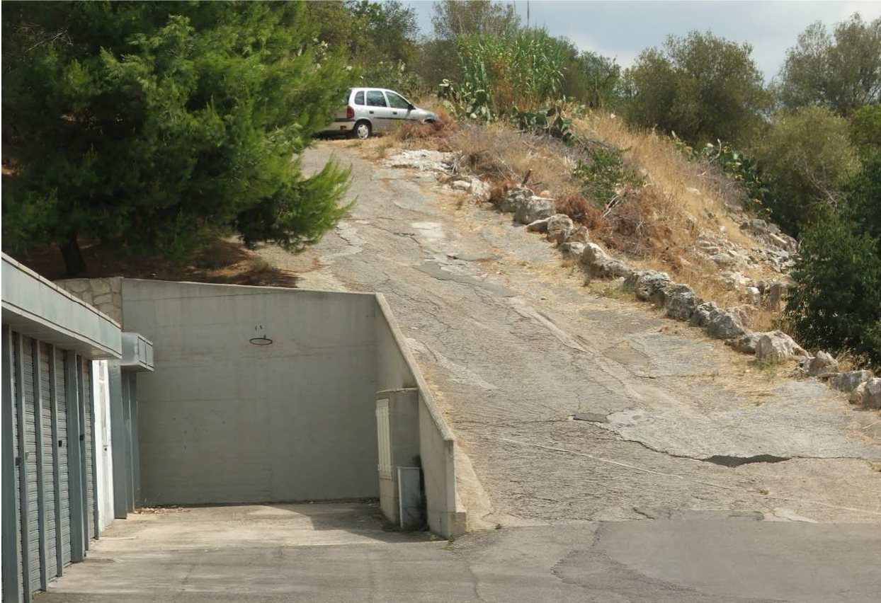
Fig.18 – Vista dell'area interessata dall'intervento con la viabilità provvisoria di cantiere utilizzata dai residenti
