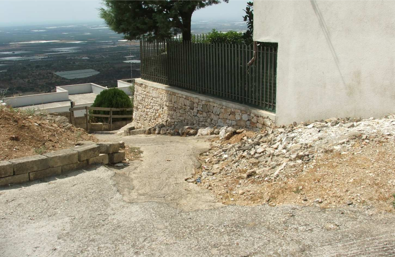
Fig.22 – Vista dell'area interessata dall'intervento e della viabilità pedonale provvisoria di cantiere utilizzata dai residenti
