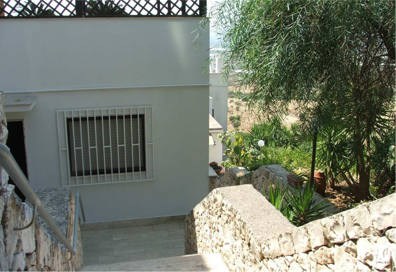
Fig.8 – Vista degli edifici esistenti nella zona C.e.2.4 di intervento
