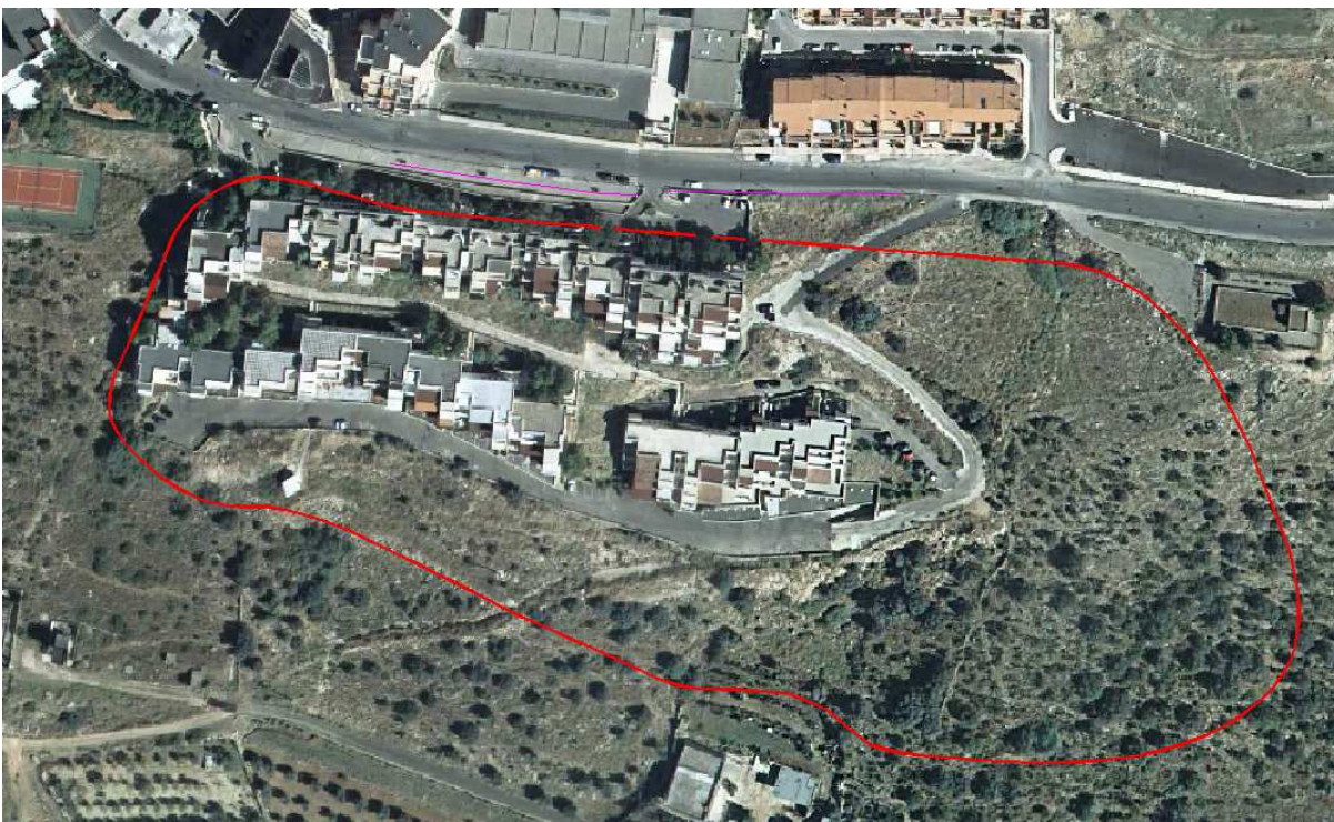
Fig.25 – Immagine satellitare del Comparto C.e.2.4 (evidenzia la parte Ovest edificata e priva di opere di urbanizzazione)
