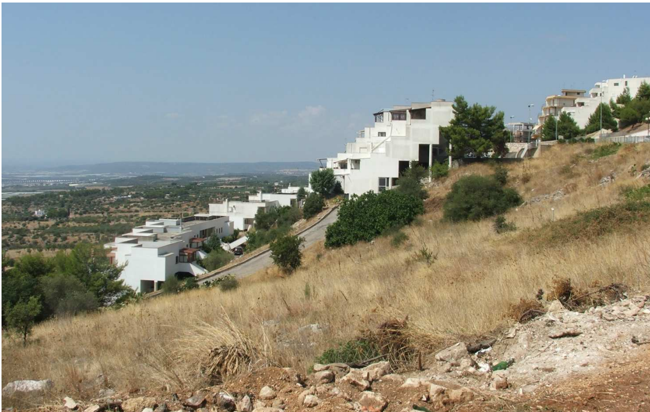
Fig.3 – Vista dell'area interessata dall'intervento.
