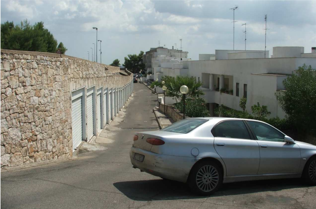
Fig.6 – Vista degli edifici esistenti nella zona C.e.2.4 di intervento
