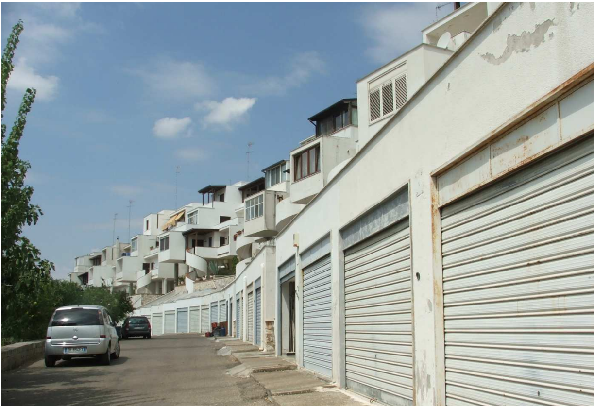
Fig.13 – Vista degli edifici e della viabilità esistenti nella zona C.e.2.4 di intervento
