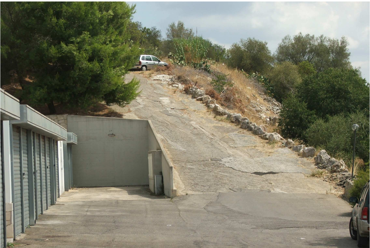
Fig.17 – Vista dell'area interessata dall'intervento con la viabilità provvisoria di cantiere utilizzata dai residenti
