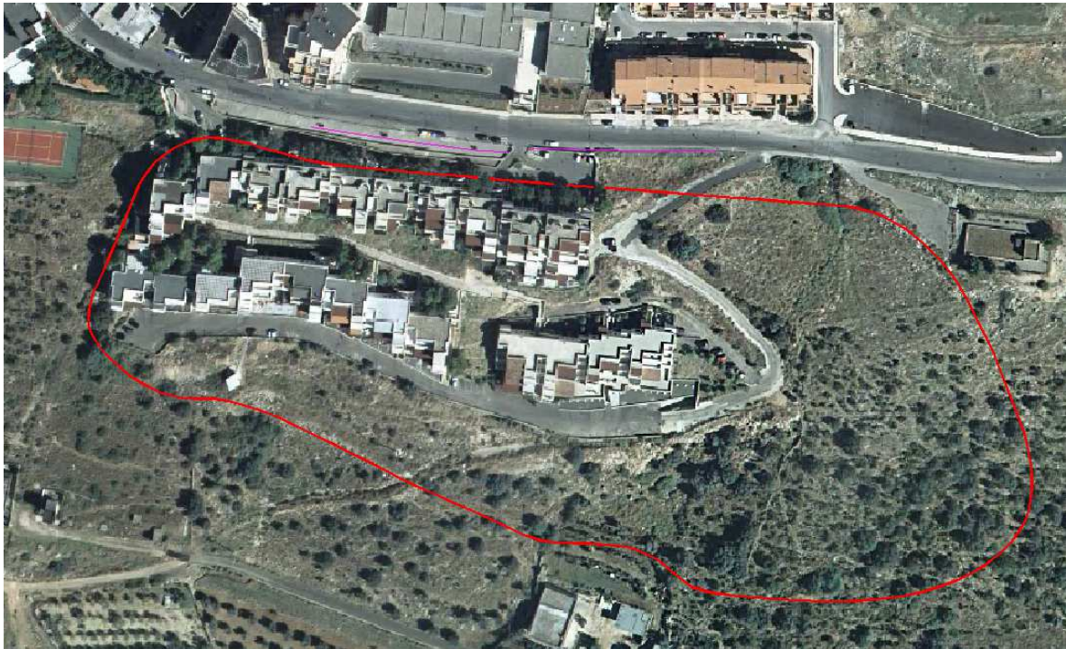
Fig.31 – Immagine satellitare del Comparto C.e.2.4 (evidenzia la parte Ovest edificata e priva di opere di urbanizzazione)
