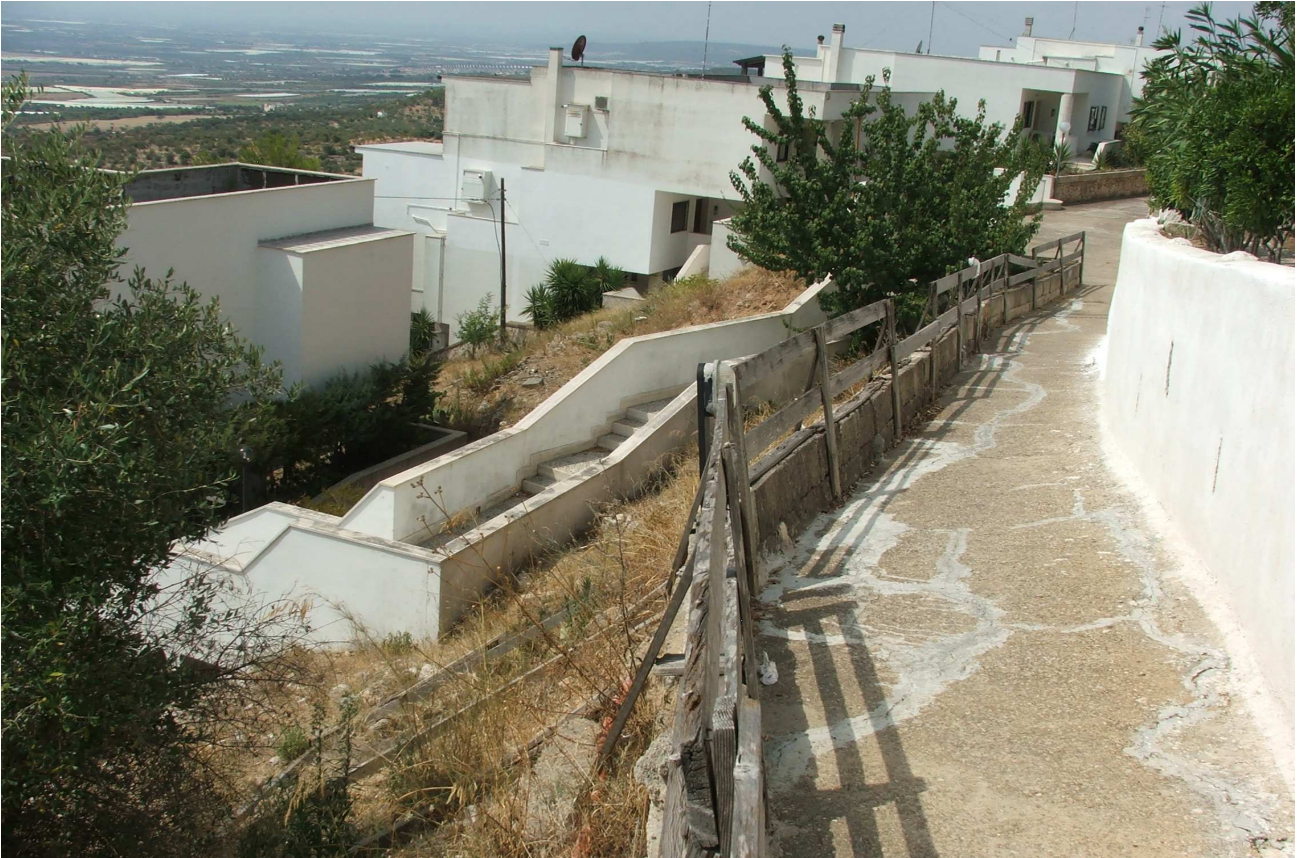
Fig.23 – Vista dell'area interessata dall'intervento e della viabilità pedonale provvisoria di cantiere utilizzata dai residenti
