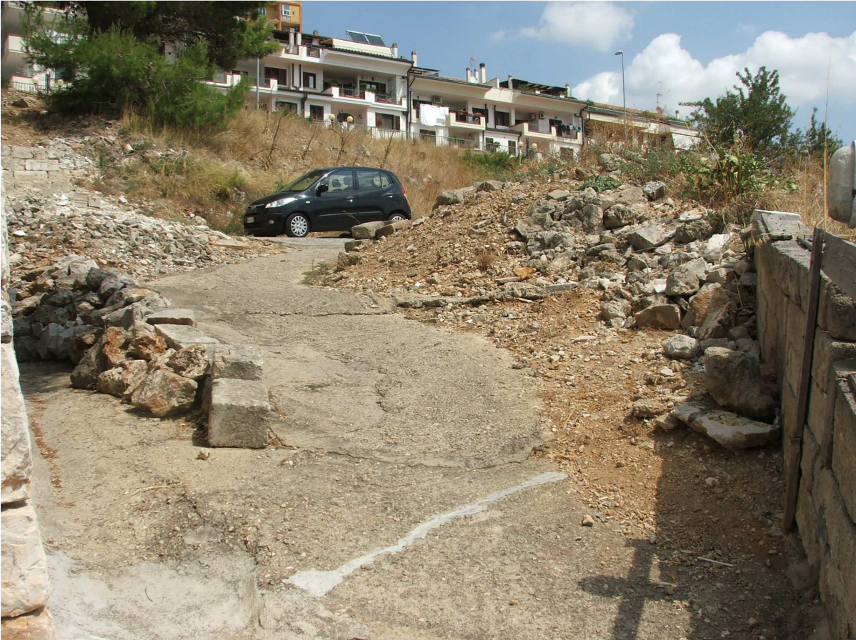
Fig.24 – Vista dell'area interessata dall'intervento e della viabilità pedonale provvisoria di cantiere utilizzata dai residenti
