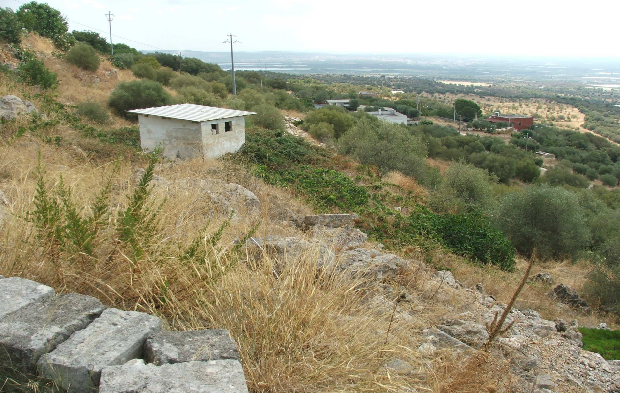
Fig.16 – Vista dell'area interessata e del vano pompa di sollevamento della fognature a servizio degli edifici esistenti nel C.e.2.4
