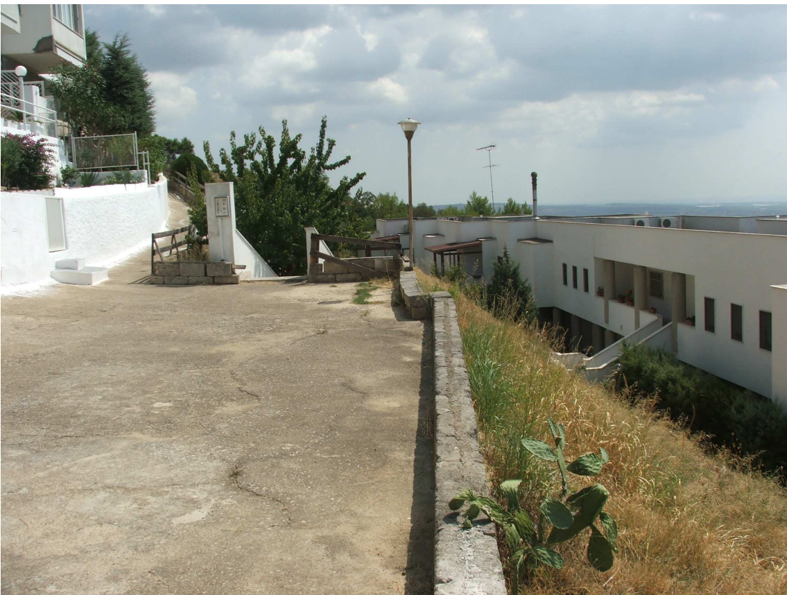
Fig.11 – Vista degli edifici esistenti nella zona C.e.2.4
