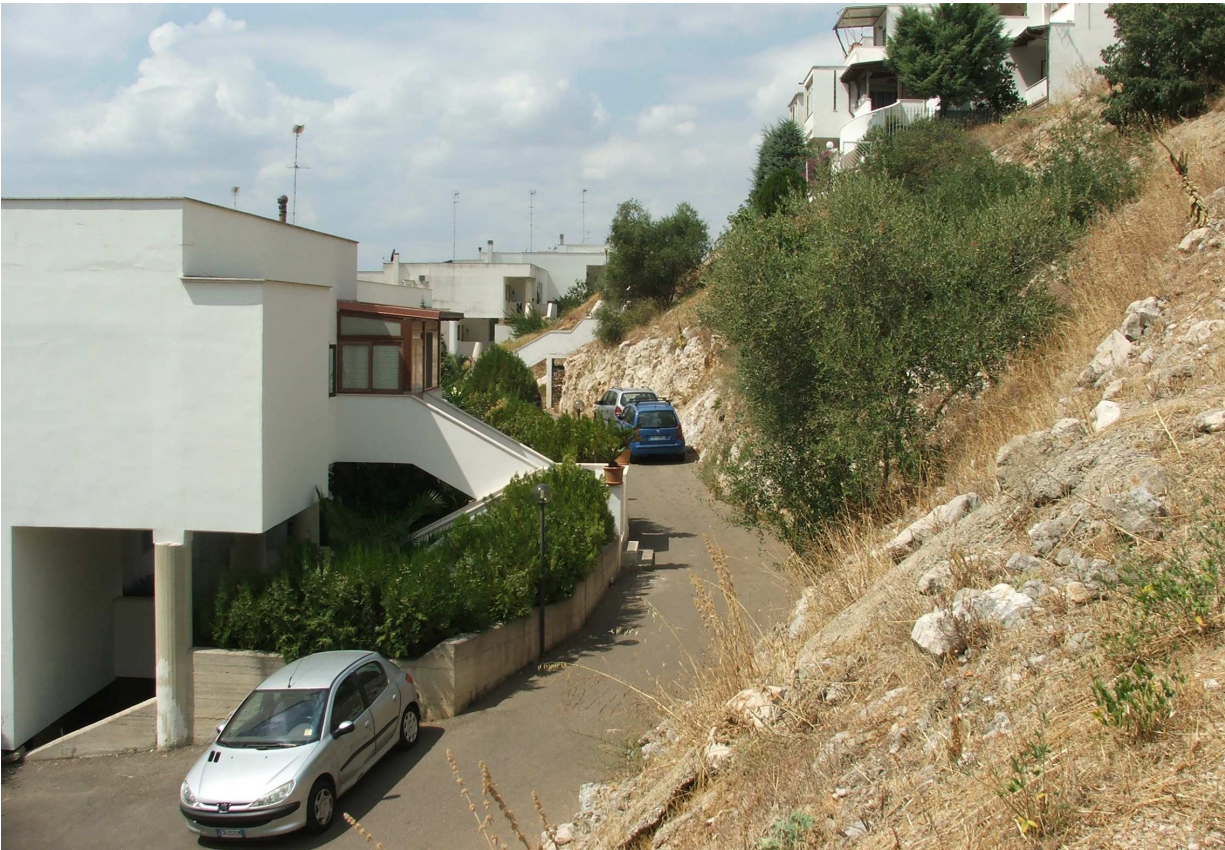
Fig.20 – Vista degli edifici esistenti nella zona C.e.2.4
