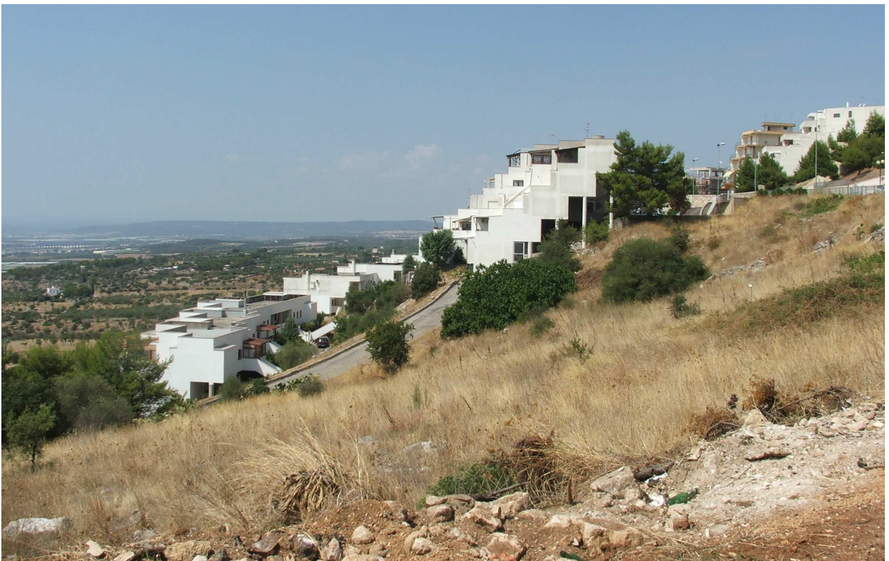
Fig.3 – Vista dell'area interessata dall'intervento.
