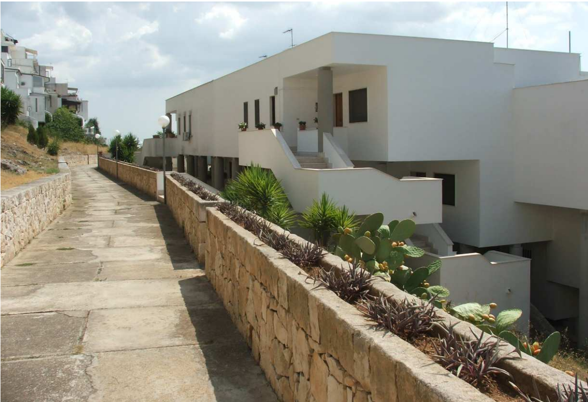
Fig.10 – Vista degli edifici esistenti nella zona C.e.2.4
