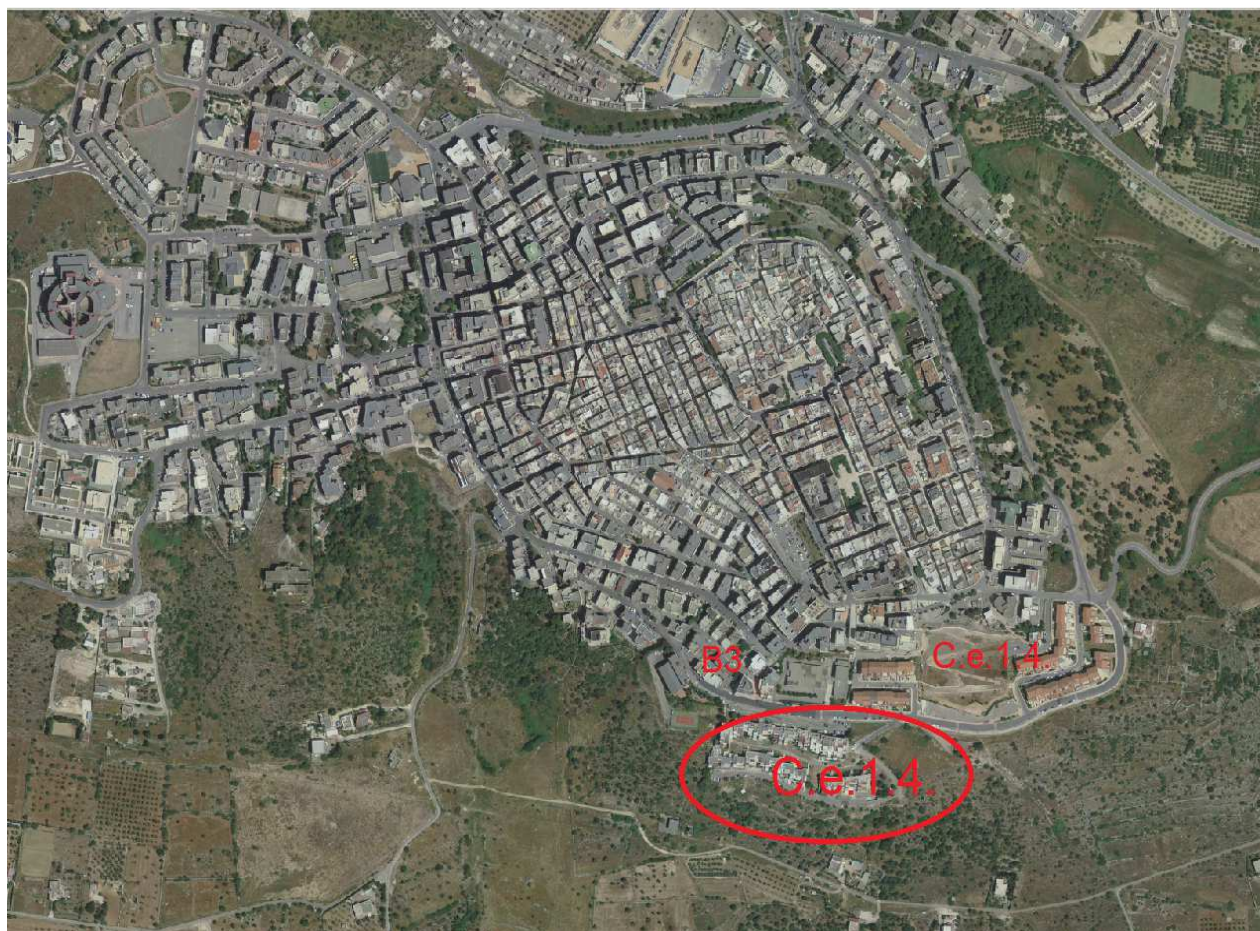
Fig.1 – Immagine satellitare del territorio di Mottola con evidenziata l'area interessata dall'intervento
