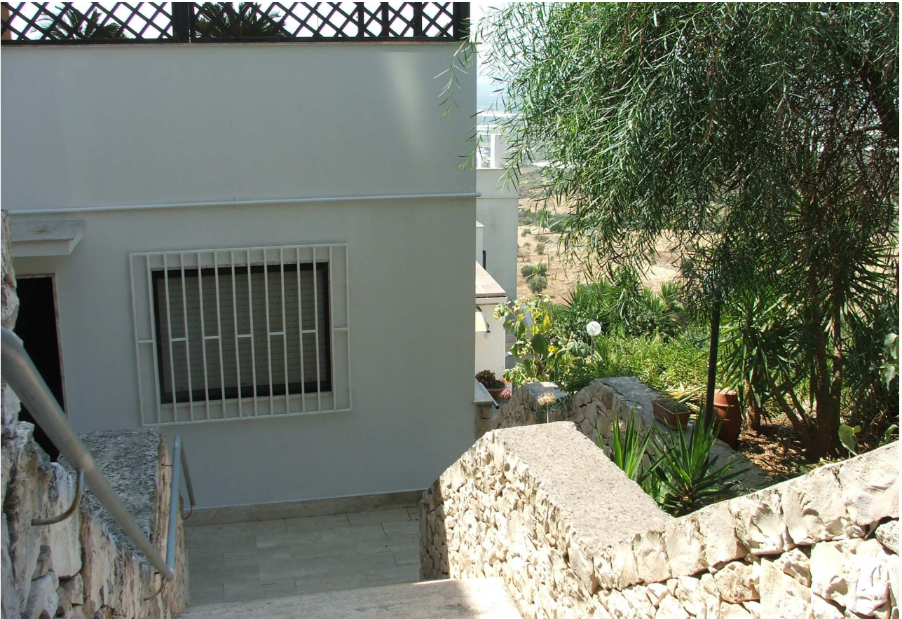
Fig.8 – Vista degli edifici esistenti nella zona C.e.2.4 di intervento
